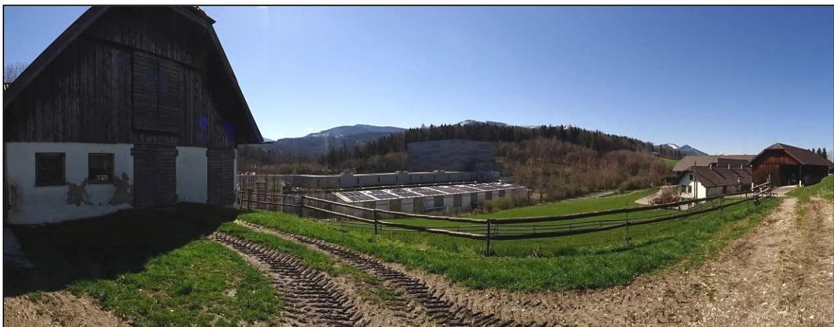
Abbildung 4 nordwestl. Plangebiet, links zu „Emeralm“ und Weideflächen, Bildmitte tiefer gelegener Betriebsstandort der Adelholzener Alpenquellen GmbH mit westl und südl. angrenzenden Waldbeständen am Ramberg, rechts weitere Gebäude des Primushofs (Blick nach Westen)
