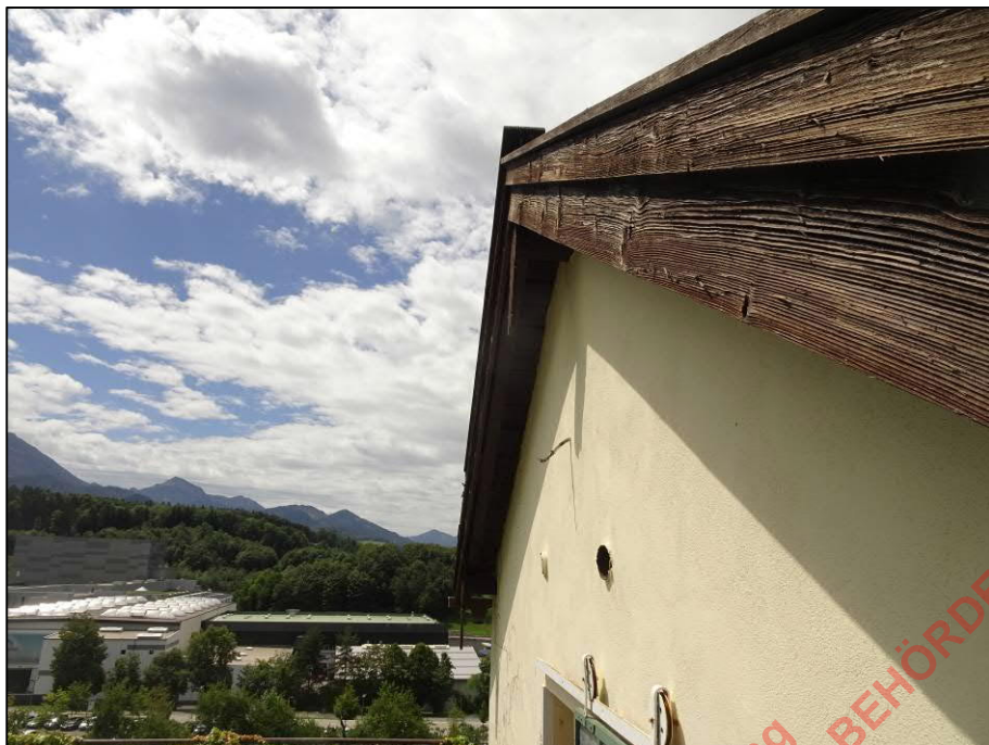
Abbildung 13 Windbretter an Nebengebäude der Gärtnerei (August 2023)
