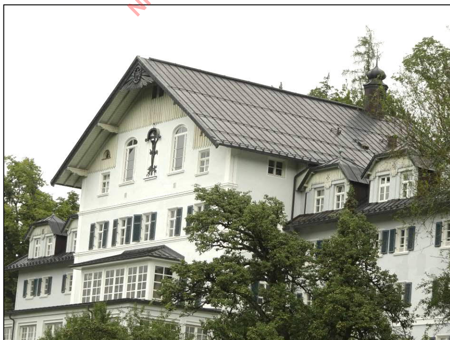
Abbildung 14 Kurhaus / ehem. Schwesternwohnheim von Südosten mit Haupttrakt und westlichem bzw. östl. Seitentrakt (Gebäude Bad Adelholzen Nr. 2, August 2023)
