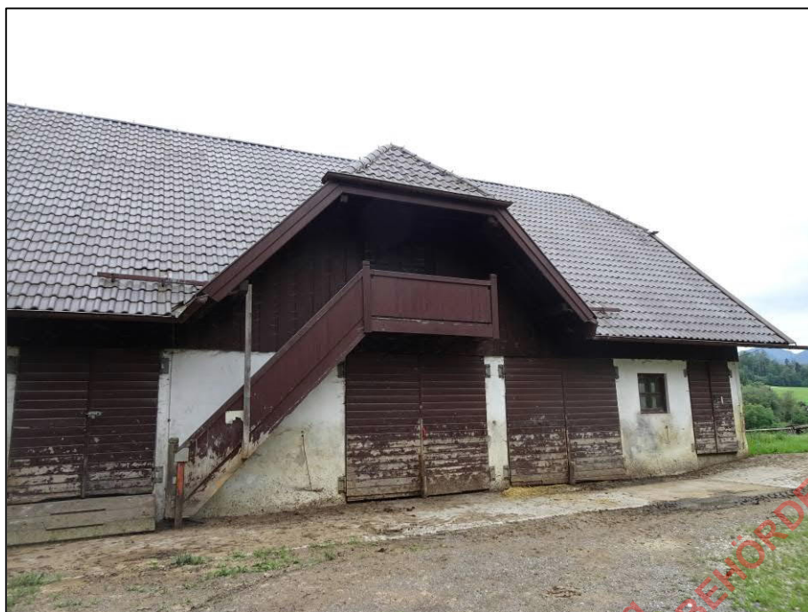
Abbildung 11 Gebäude Nr. 10 – alter Schafstall bzw. s. g. „Emeralm“
