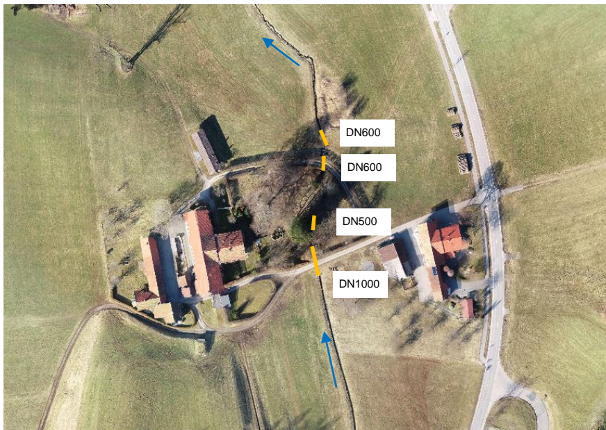
Abbildung 2.2: Siedlungsbereich Thalham mit Bestandsverrohrungen (aquasoli, 2022a)
